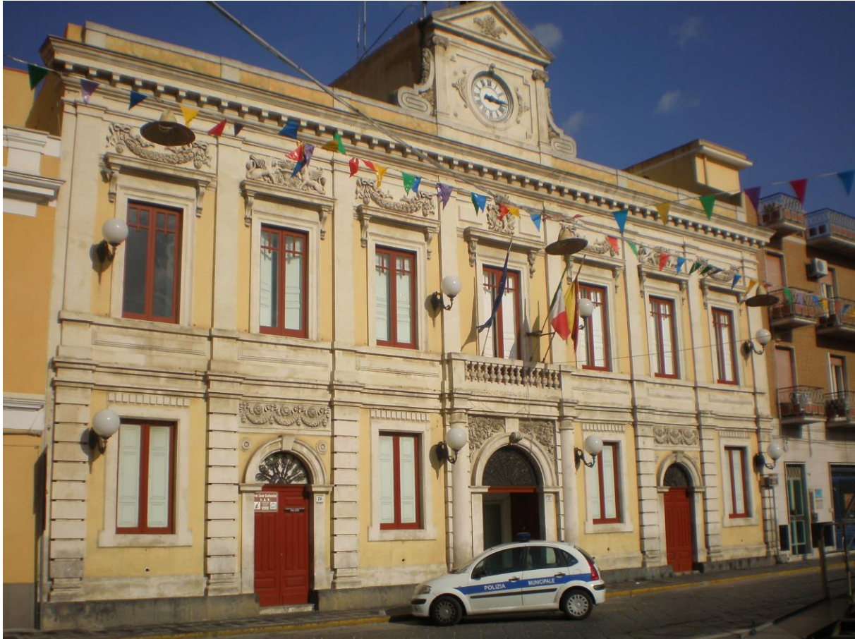
Palazzo della municipalità - Sede storica.
